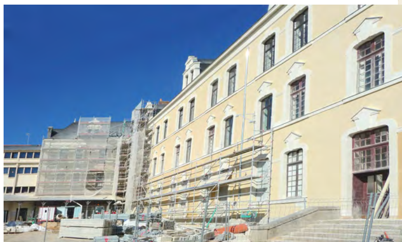
la cour des moyens en chantier
