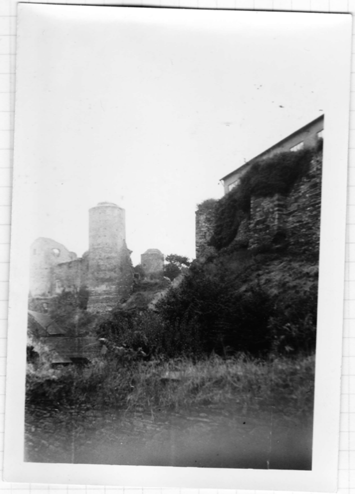
Vue de la route du dessus
