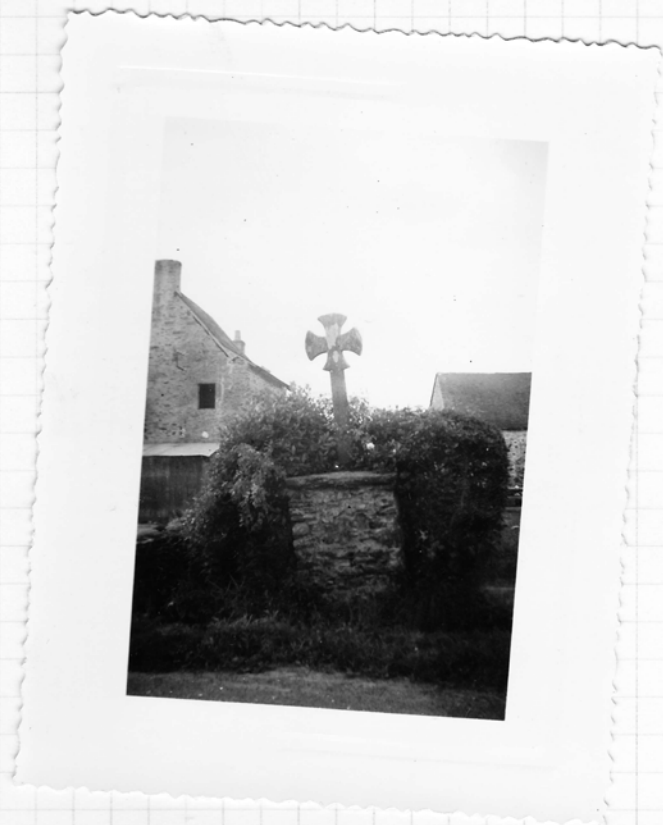
Sur la route de la Babinière, après le pont (casse de route)
